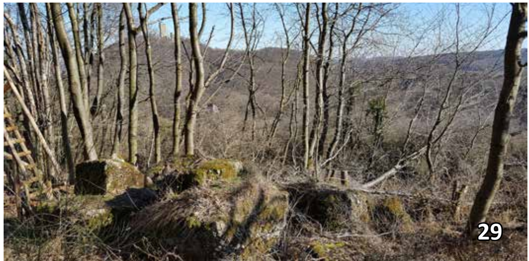
Bild 29: Unmittelbar vor dem Steilhang, der ins Tal des Brohlbaches hinabführt, finden sich Reste der Betonkonstruktion, auf denen der Tragmast der Seilbahn montiert war. Von hier aus ging es beachtliche 735 m freischwebend in Richtung Burg Olbrück, deren Bergfried man zwischen den Bäumen erkennt. Bild (21. Februar 2021): Volkhard Stern
