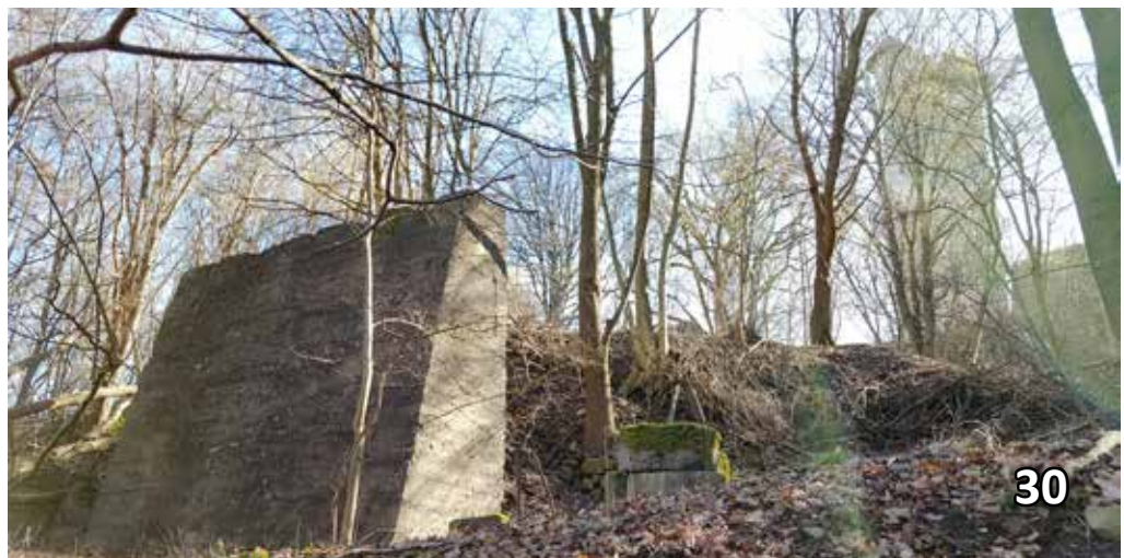
Bilder 30-31: Der gewaltige Sockel der Spannstation Olbrück befand sich nur wenige Meter vom Bergfried der Burg Olbrück (siehe im Hintergrund hinter den Bäumen) entfernt. Er ist bis heute gut erhalten. Die Konstrukteure der Seilbahn nutzen die exponierte Lage des Burgbergs geschickt zur Überwindung der beachtlichen Höhendifferenz zwischen dem Basaltwerk in Oberzissen und dem Steinbruch an der Hannebacher Ley. Bilder (28. Februar 2021): Volkhard Stern
