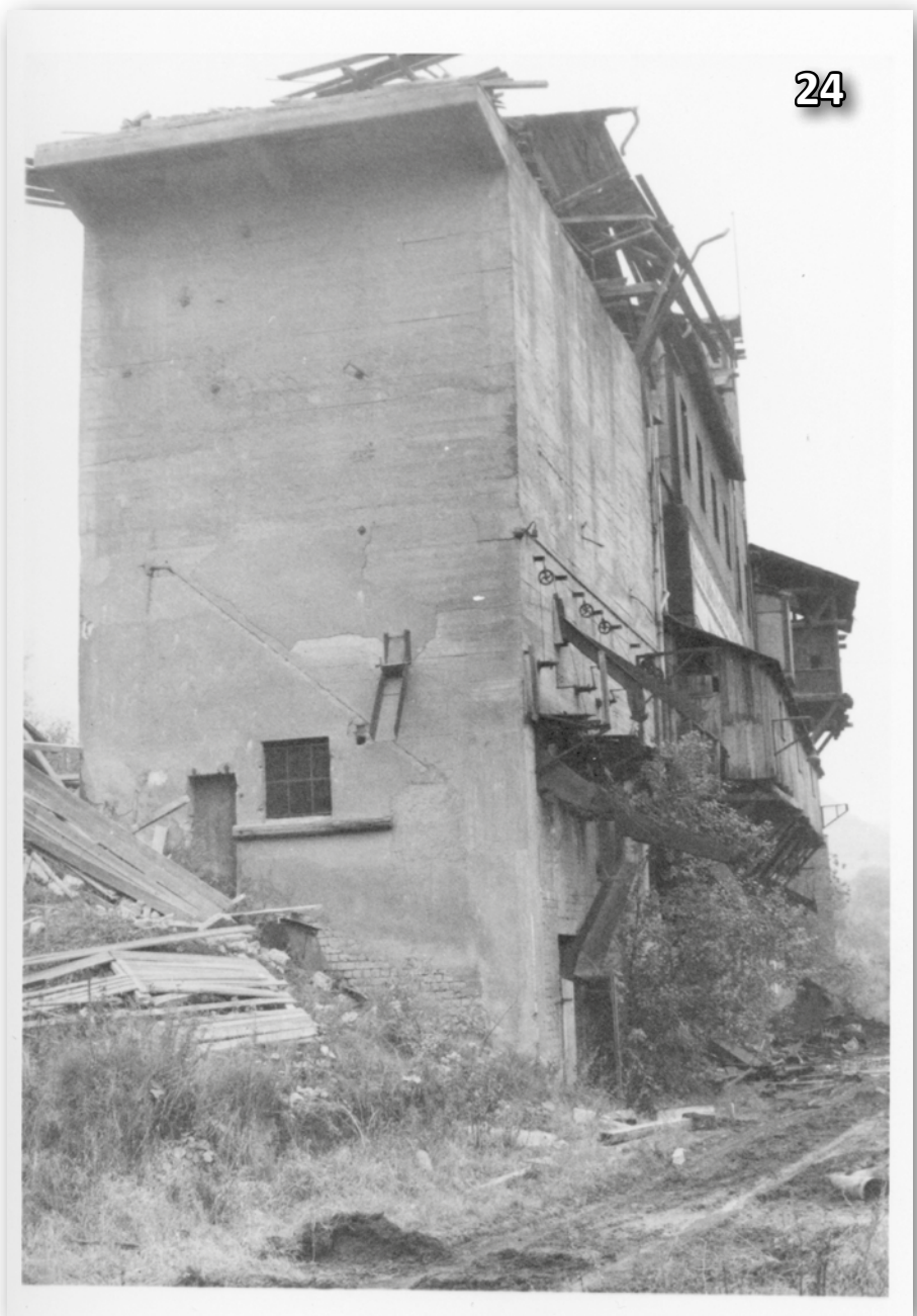
Bild 24: Abriss des Basaltwerks Oberzissen im Jahr 1975. Die Schüttrutschen, unter denen die Waggons beladen wurden, sowie Gleisreste sind zu erkennen. Bild: Alfons Dietz
