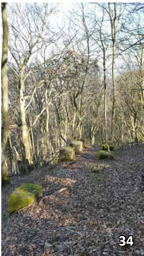
Bild 34: Auf dem Olbrücker Burgberg findet man auch diese Betonsockel des früher bergab in Richtung Oberzissen installierten Traggerüsts. Bild (28. Februar 2021): Volkhard Stern
