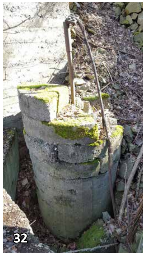
Bild 32: Die tonnenschweren Gewichte der Spannstation dienten dazu, die Seile stramm zu halten. Sie sind unterhalb der Burg Olbrück ebenso erhalten wie Reste des geflochtenen Drahtseils. Bild (28. Februar 2021): Volkhard Stern
