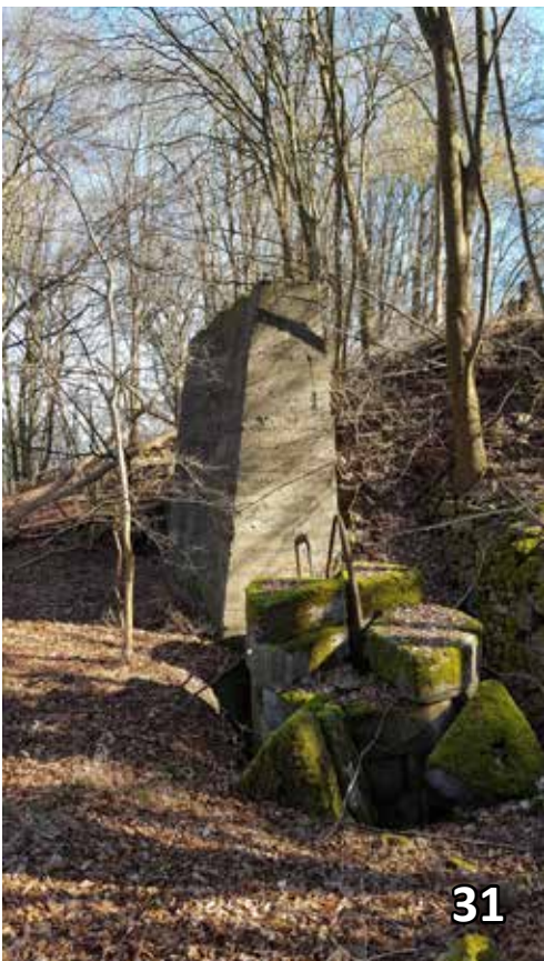
Bilder 30-31: Der gewaltige Sockel der Spannstation Olbrück befand sich nur wenige Meter vom Bergfried der Burg Olbrück (siehe im Hintergrund hinter den Bäumen) entfernt. Er ist bis heute gut erhalten. Die Konstrukteure der Seilbahn nutzen die exponierte Lage des Burgbergs geschickt zur Überwindung der beachtlichen Höhendifferenz zwischen dem Basaltwerk in Oberzissen und dem Steinbruch an der Hannebacher Ley. Bilder (28. Februar 2021): Volkhard Stern
