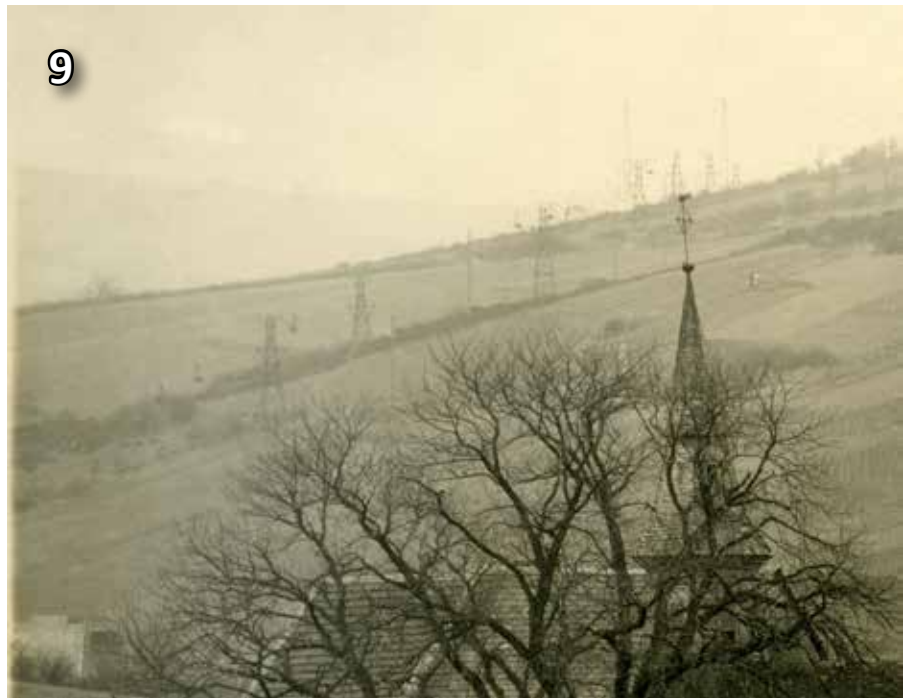
Bild 9: Mastenkette der Seilbahn von Oberzissen zum Steinberg, um 1930. Im Vordergrund der Kirchturm von Oberzissen. Bild: Sig. Alfons Dietz
