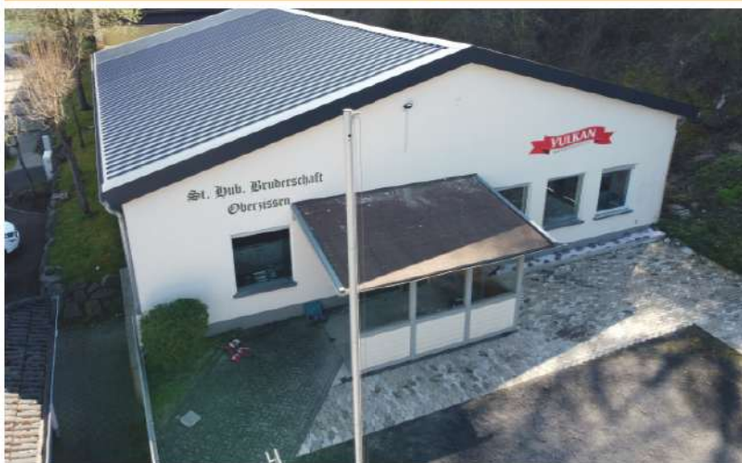
April 2025: Die neue Schützenhalle nach dem Wiederaufbau aus der Vogelperspektive.
