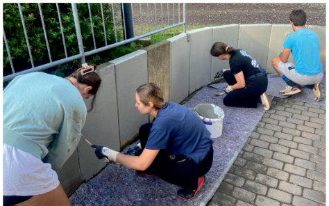
September 2023: 15 freiwillige junge Menschen aus ganz Europa haben am Internationalen Workcamp Oberzissen / Niederdürrenbach teilgenommen. Viele Arbeiten im Dorf wurden verrichtet: hier Malerarbeiten an der Brohltalhalle.
