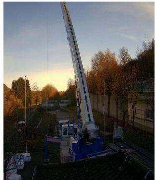
Oktober 2023: Die Sanierung der durch einen Brand geschädigten Schützenhalle geht langsam voran. Die neue Dacheindeckung wurde verlegt.
